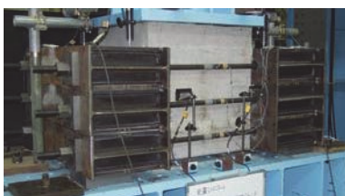
① 既存柱に鋼製治具を圧着
