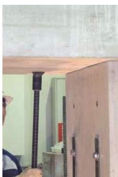
写真-6 挿入状況
