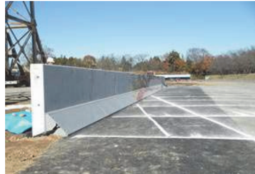
写真一 6 (2) 車両衝突試験後の状況 (条件 A)
