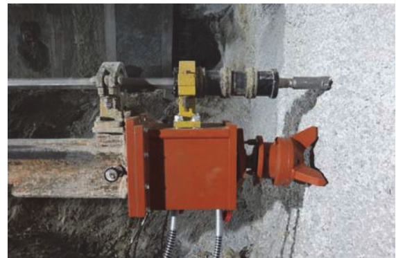
写真-3 固定治具設置状況
