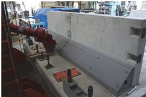
写真-2 ひび割れ状況 (載荷試験終了時)
