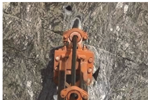
写真-2 穿孔時のロッドの状況
