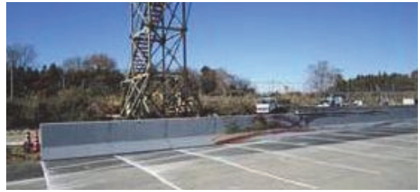
写真一 6 (1) 車両衝突試験後の状況 (条件 A)
