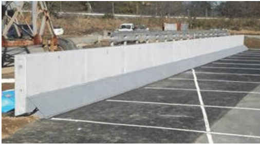
写真-3 プレキャスト高欄設置状況 (条件A)
