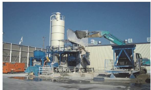
写真-3 不溶化処理の状況
