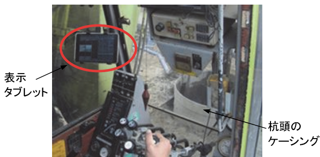
写真-2 オペレータ室の機器設置状況
