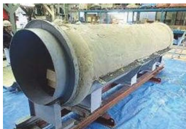
写真-1 7時間経過した中詰材の充填状況
