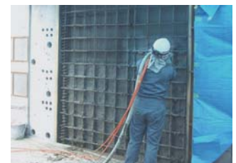
写真-1 吹付け施工状況
