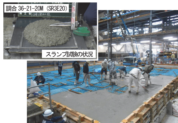
写真-1 超高耐久低収縮コンクリートのスラブ基盤への打込み状況
