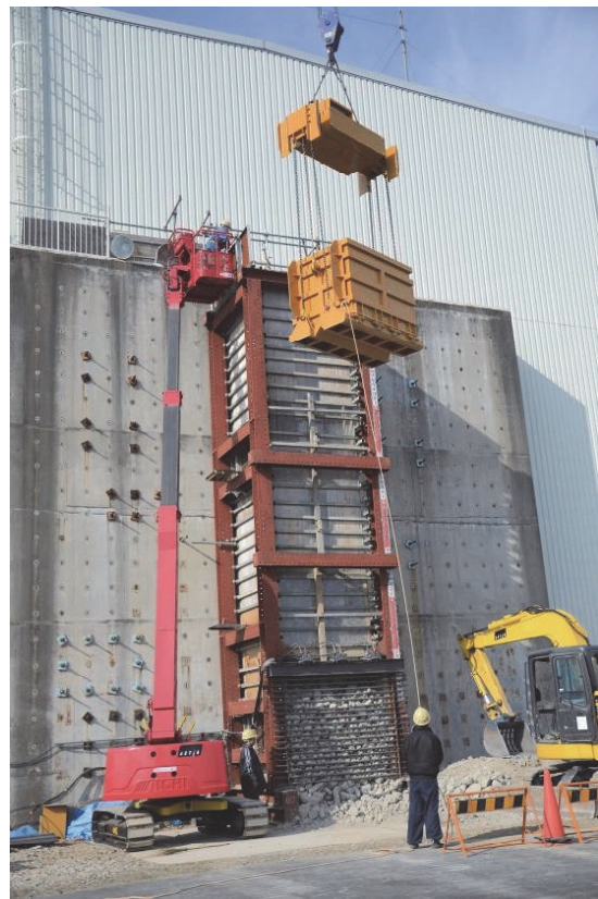
写真-5 シャフトの外観（実験状況）
