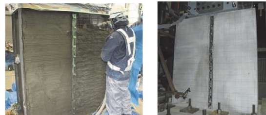
(c) モルタル吹付け (d) 補強完了
