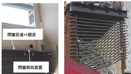
写真-8 シャフト内観 写真-9 閉塞時の排出口
