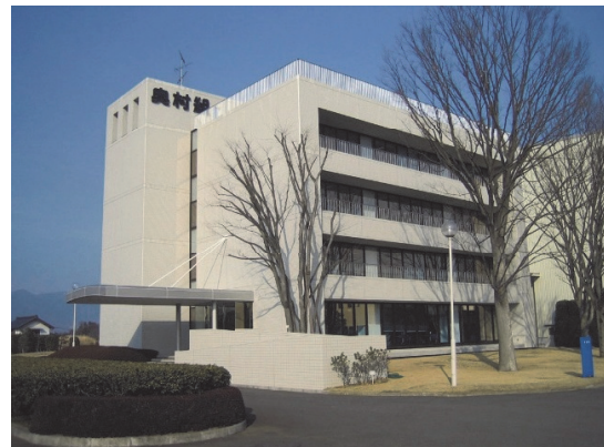
写真-1 対象建物の外観
