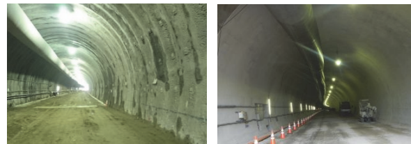
図-8 トンネル内部状況
