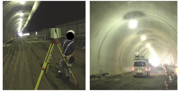
図-4 TLS、MMS の計測状況
