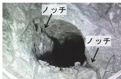
写真-3 ノッチ深さの確認(移動速度500mm/min)
