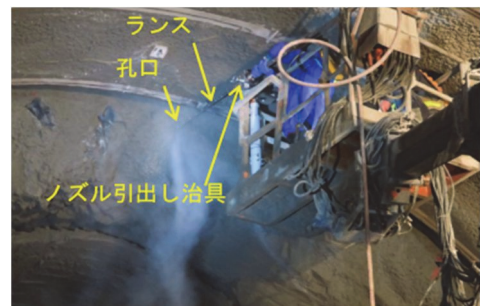
写真-6 ノッチ形成作業の状況
