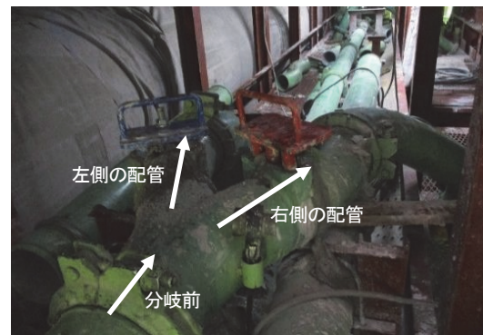
写真-4 配管分岐部
