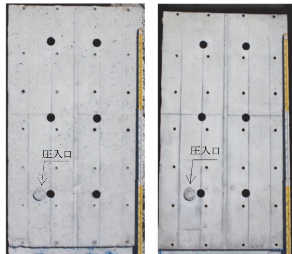
写真-3 中流動コンクリート使用時の仕上がり状況
