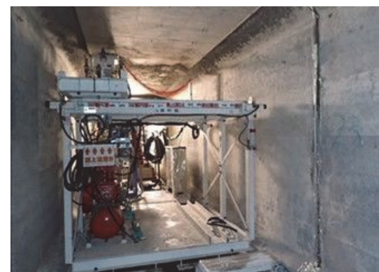
写真-13 小型研掃装置による施工状況
