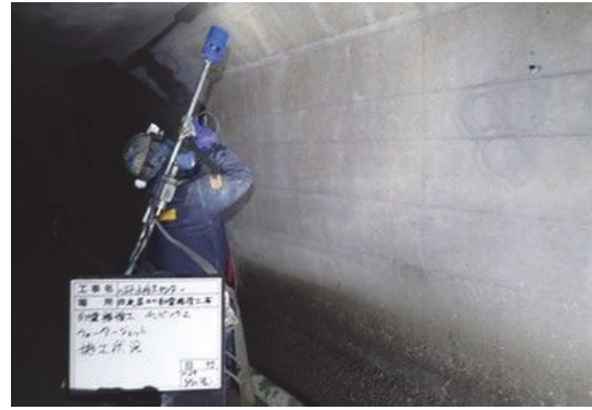
写真-14 WJによる施工上状況
