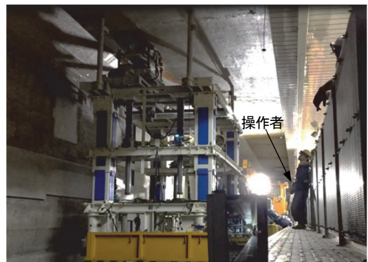
写真-7 研掃装置による施工状況
