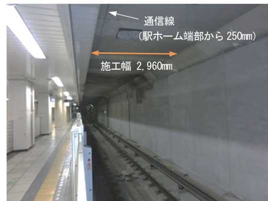
写真-4 適用箇所（地下鉄）
