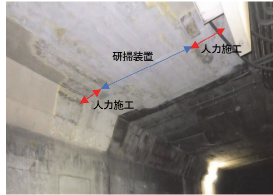
写真-10 研掃による仕上がり面の状況
