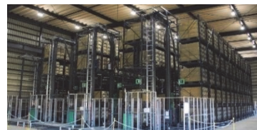
写真－1 自動倉庫ラック
