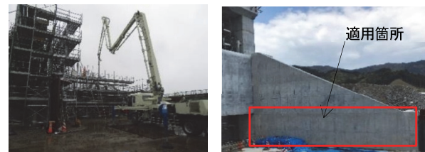
写真-5 山田町大沢水門における現場適用 (左: 打設時、右: 打設後)
