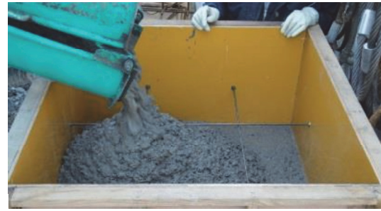
写真-2 型枠への打設状況
