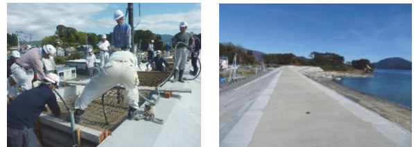
写真-4 山田町織笠漁港における現場適用 (左: 打設時、右: 完成時)
