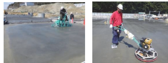
工程： 羽根押え 鏡面仕上げ 機械： 騎乗式 モスキート
