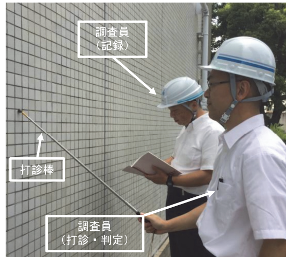
写真-1 現状の打診調査状況（例）
