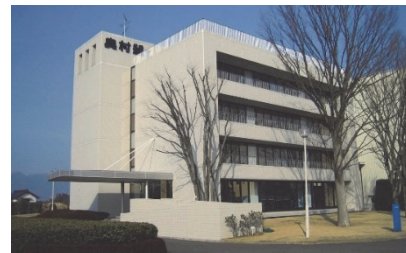
写真-1 竣工後30年が経過した免震建物
