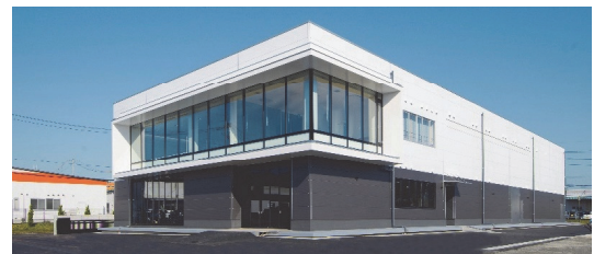
写真-1 オールラウンド免震を適用した建物
