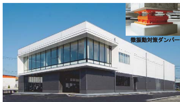
写真-1 オールラウンド免震を適用した建物
