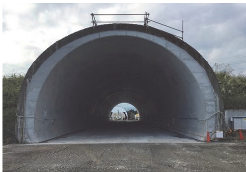
写真一六 実大模擬トンネルの外観
