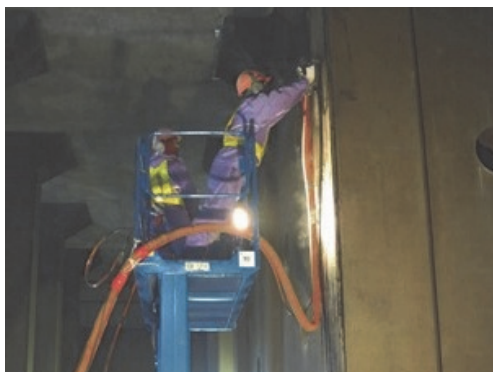
写真－1 人力による壁面の研掃作業
