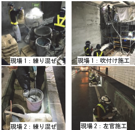
写真-2 適用現場の施工状況
