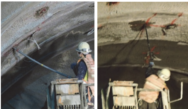
写真-1 定着材の充填 写真-2 ロックボルトの挿入
