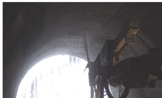
写真-3 模擬トンネル吹付け状況
