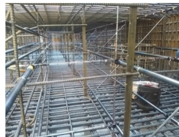
写真-5 クーリングパイプ配置(躯体内)
