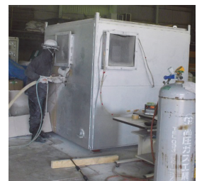
写真-3 吹付け状況
