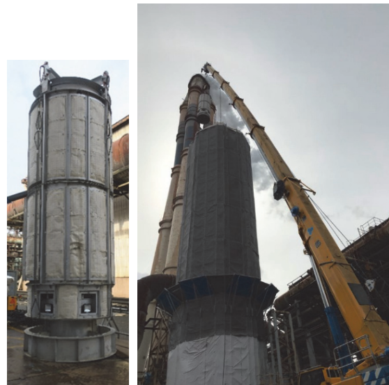
写真-4 吹付け装置の全景および吊り込み状況
