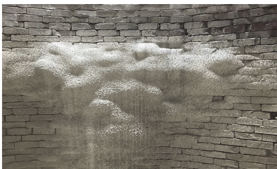
写真-9 吹付け面の仕上がり状態
