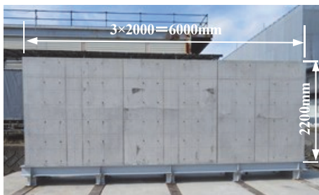
写真-3 RC壁試験体設置状況
