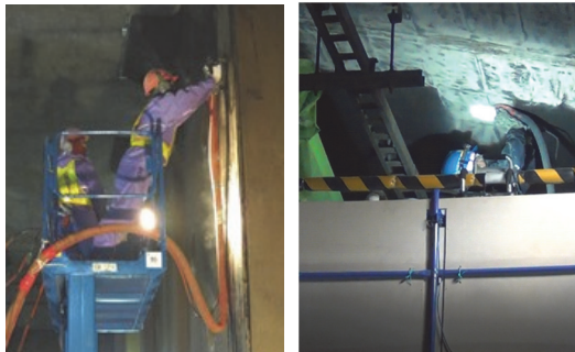
写真－1 人力による壁面の研掃作業
