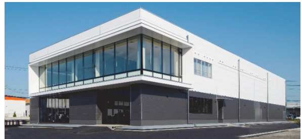
写真-1 建物外観
