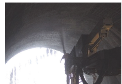
写真-2 模擬トンネルの吹付け試験施工
