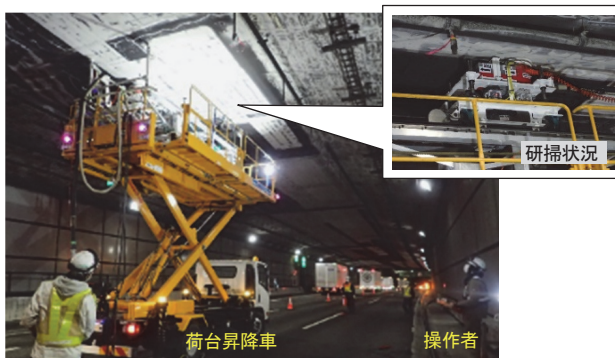
写真-2 施工状況
