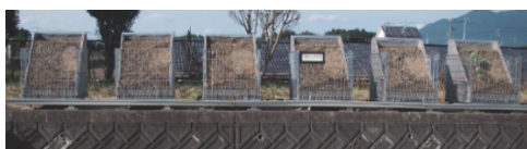
写真-2 盛土試験状況
