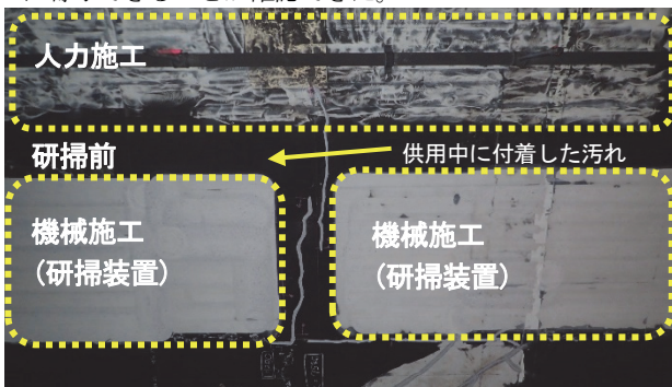
写真-12 改良した研掃装置と人力による研掃面
