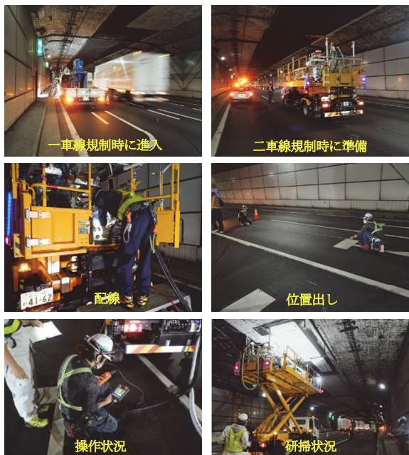
写真-9 施工状況
