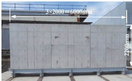
写真-3 RC壁試験体設置状況
