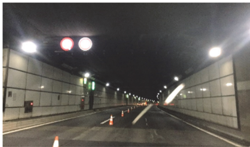
写真-6 適用トンネル内の状況
