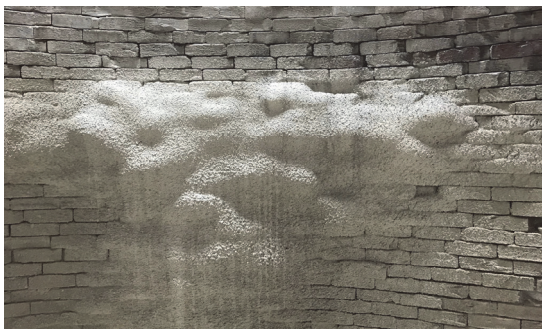
写真-9 吹付け面の仕上がり状態
