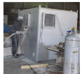
写真-3 吹付け状況
