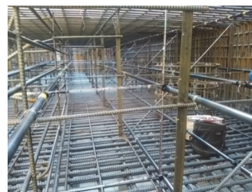
写真-5 クーリングパイプ配置(躯体内)
