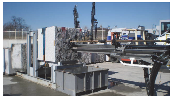
写真-1 試験体の削孔状況
