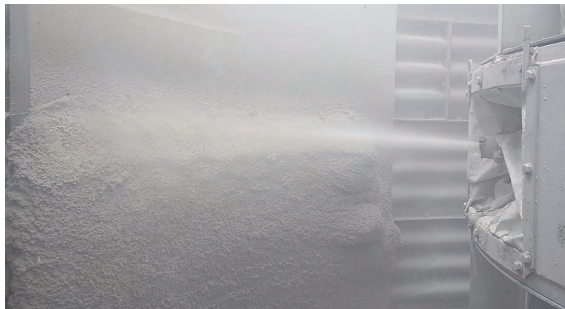
写真-8 無線遠隔操作による吹付け状況 (模擬煙突)
