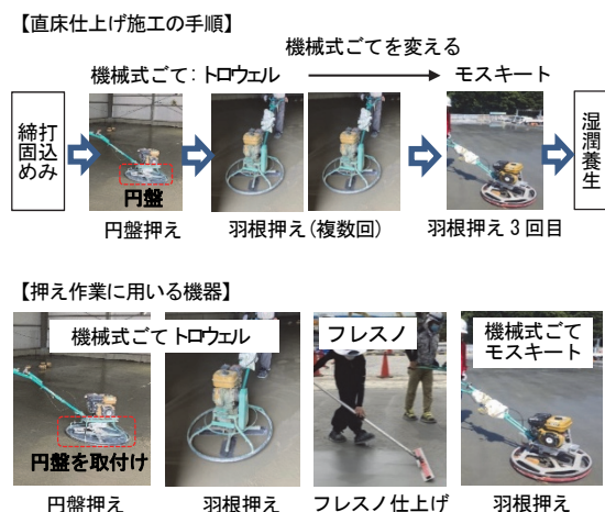
図-1 コンクリートの直床仕上げ施工の手順一例と押え作業に用いる機器
