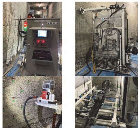
写真-2 自動削孔装置の現場適用状況
