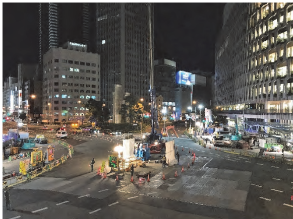
図-10 交差点を占有しての地盤改良施工状況
