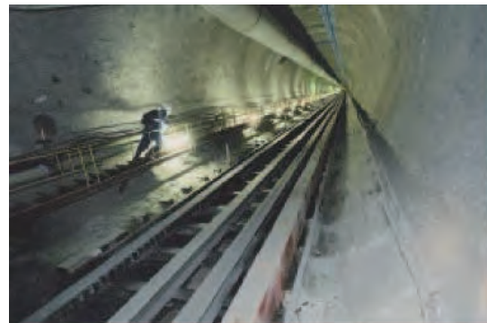
神流川発電所工事の長大斜坑
