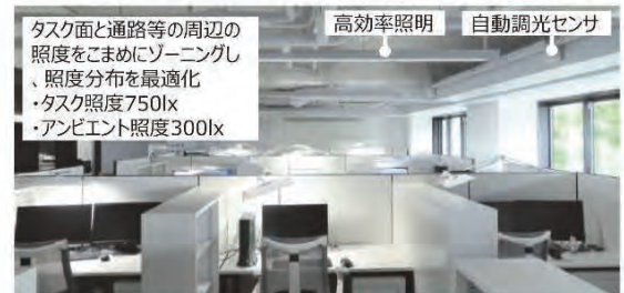
タスク・アンビエント照明空間と高効率照明、自動調光センサー
