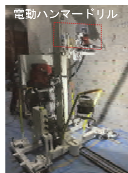
写真-2 小径用自動削孔装置
