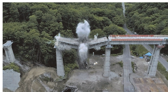
既設水路橋の発破解体（PC桁）
