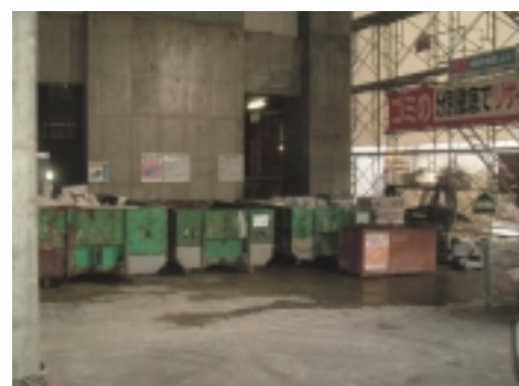
ALC・廃プラ・コンガラ・スクラップ分別状況
