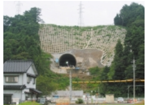
魚津トンネル上越方坑口・鉄塔状況
