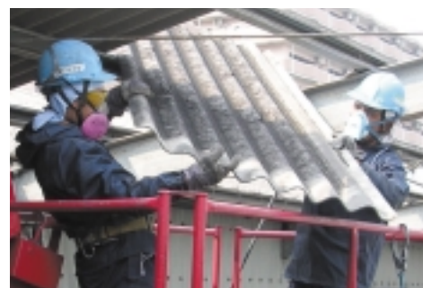
手作業によるスレート屋根材の解体
