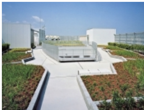
プランター方式屋上緑化システム施工例
