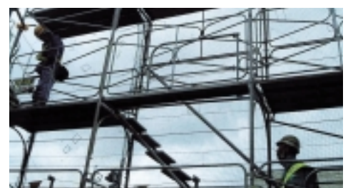
手すり先行工法による足場
