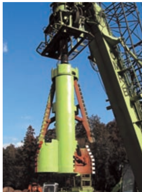
2倍掘削杭掘削機
