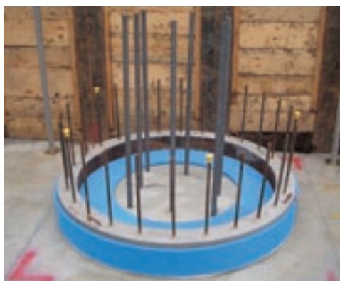
キャブテンパイル工法
