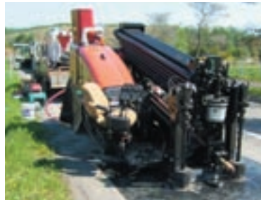
HDD工法の施工状況
