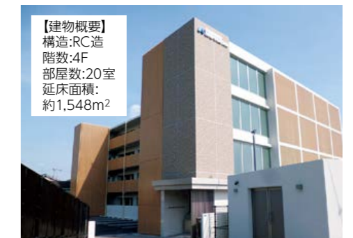
王寺本町社宅(2017年竣工 奈良県北葛城郡)
