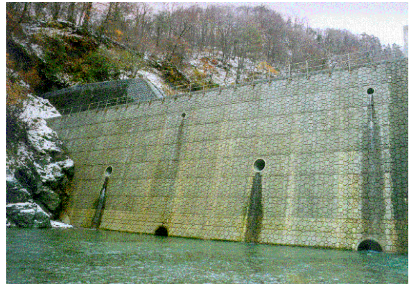
砂防ダム補強工事
