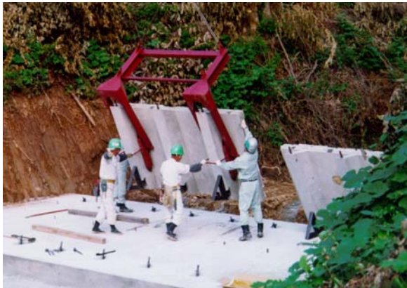
据え付け状況
